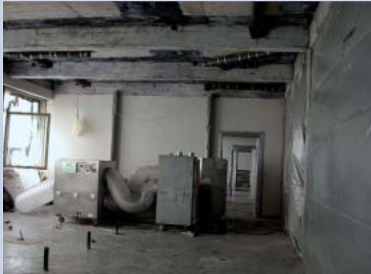
*Arbeitsschutz: Luftabsaugung während der Sanierungsarbeiten*
