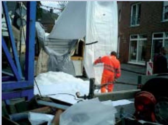
*Zur Kühlung des Schlauches während des Transportes werden große Mengen Eis benötigt.*
