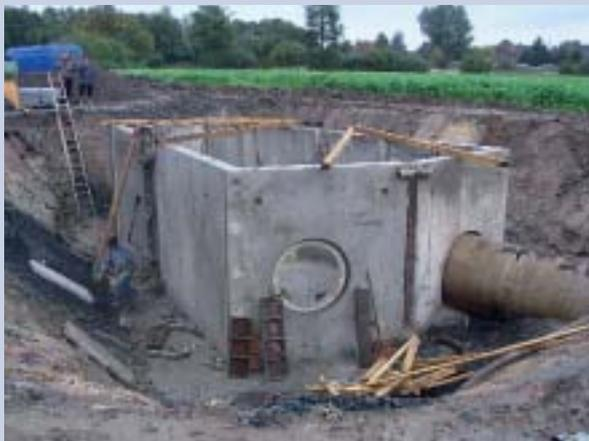
Die oberen Bilder zeigen die Kanalsanierung im Bereich der Gantenstraße. Es wird eine Gashochdruckleitung unterquert.
